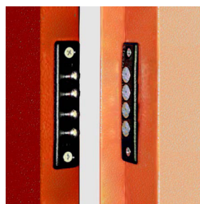
Double contacteur avec quatre plots entre vantail et dormant
